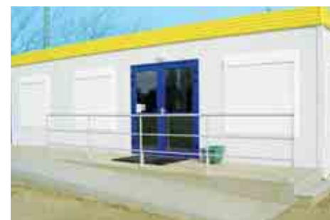
La rampe d'accès au club house
